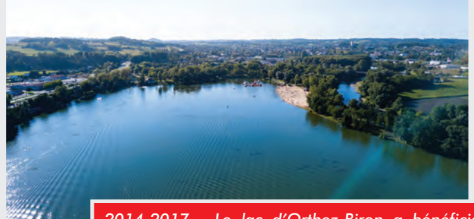
2014-2017 - Le lac d'Orthez-Biron a bénéficié d'un important chantier de traitement de l'eau.
