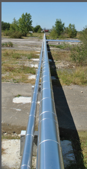
Le réseau vapeur relie les plateformes de Pardies et Moux.
