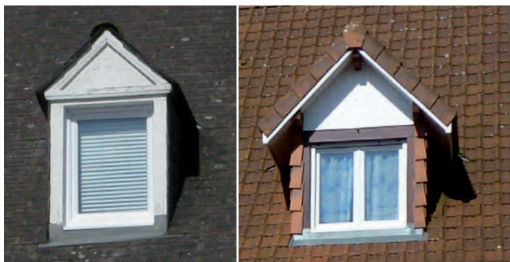
En Toiture, lucarnes à 2 pans dites Jacobines
