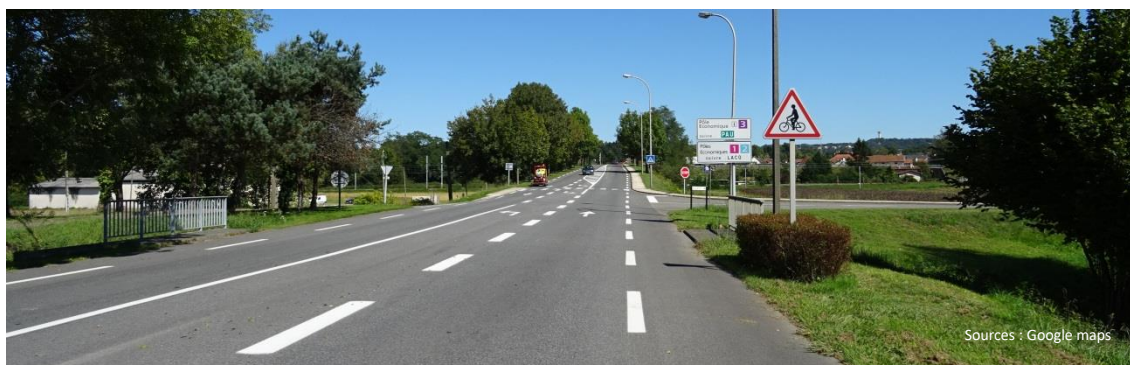
Photo: RD281 (vue vers Artix - Pont de la voie ferrée)
