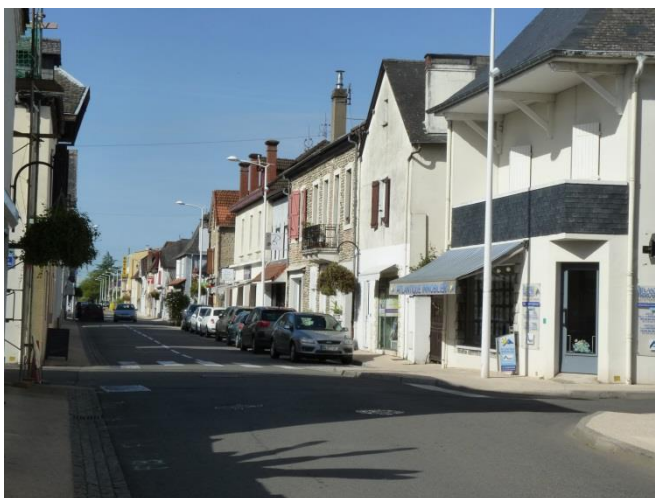
Photo : alignement de maisons anciennes le long de l'avenue de la république
