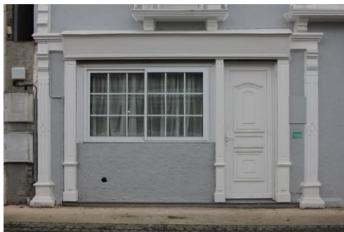
Une ancienne devanture dans les teintes de gris, transformée en entrée privative
