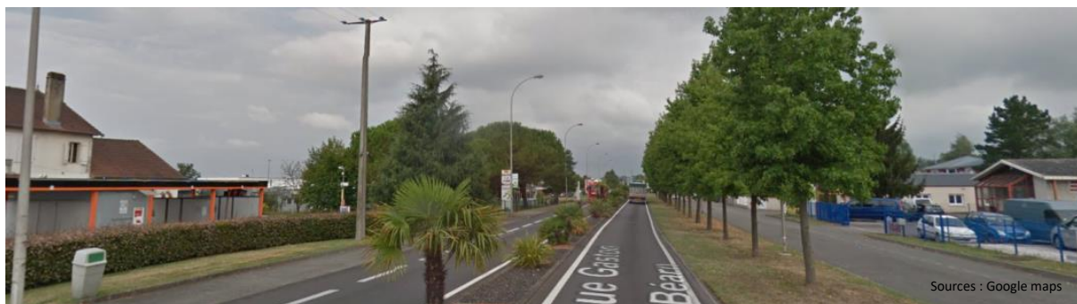
Photo: Traitement urbain de la RD817: à droite le lotissement Marcel Dassault, à gauche, la zone Eurolacq 1
