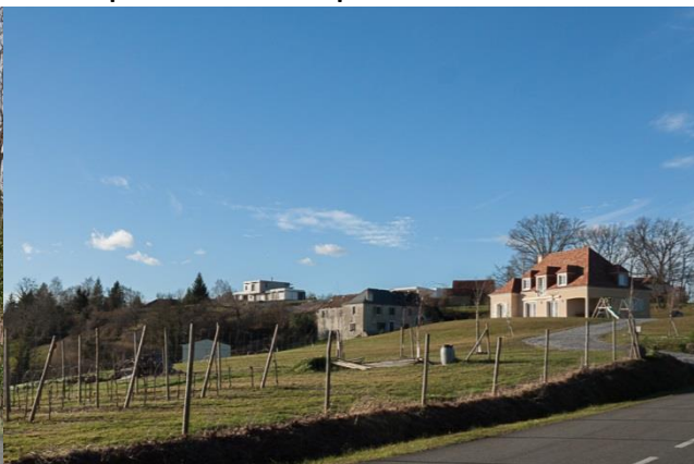
Vue du quartier Labasse depuis le sud-est
