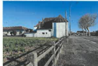
Figure 4 – Vue sur la parcelle AD428 et la « maison Mattali » (façade ouest)
