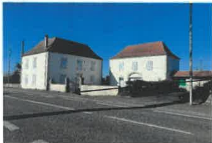
Figure 3 - Vue sur la « Maison Mattali » (parcelle AD15)
