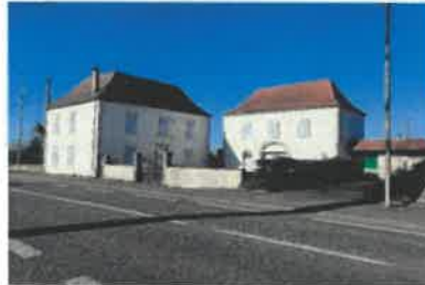
Figure 3 - Vue sur la « Maison Mattali » (parcelle AD15)
