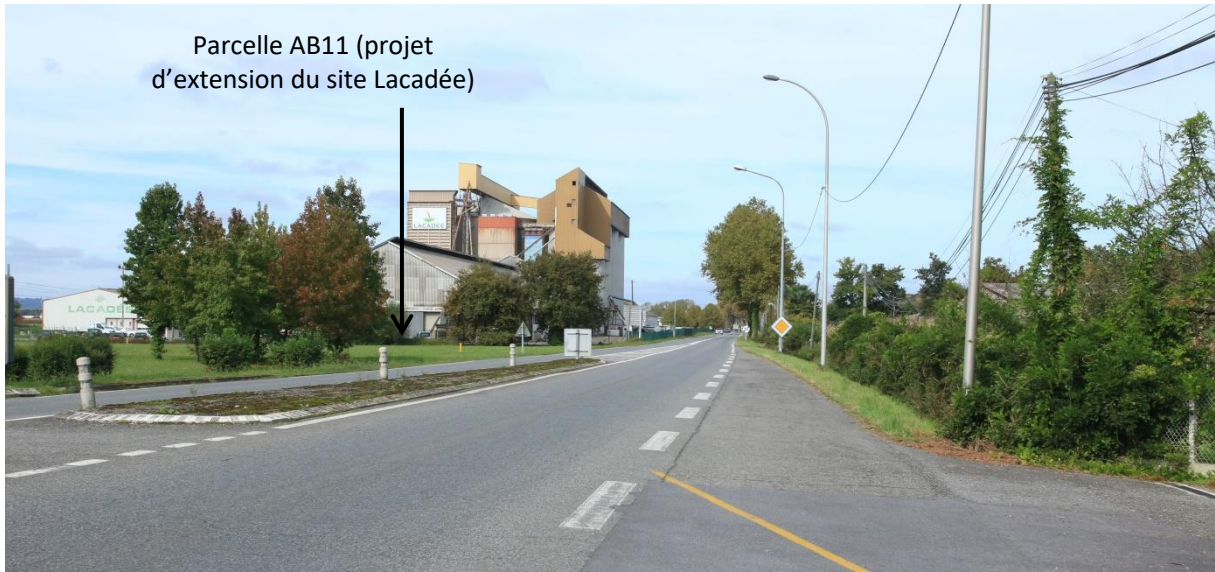
Vue 1 - Entrée depuis Lacq et vue sur l'ouest de la zone (parcelles AB350 au premier plan, AB11 au second plan devant les silos Lacadée)
