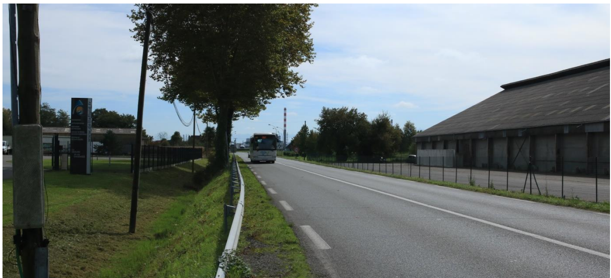
Vue 2 - Entrée depuis Orthez - A droite, les bâtiments des silos Lacadée (commune de Mont)
