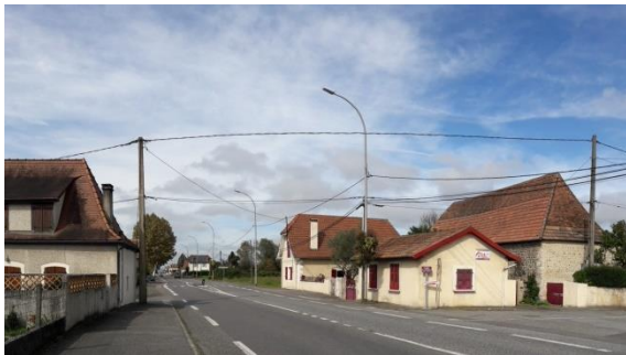
Figure 26 - Le bâti traditionnel
