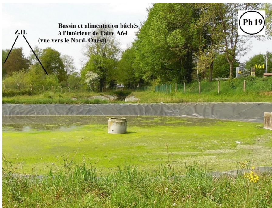
Photo 19 - Bassins de l'aire d'autoroute A64
