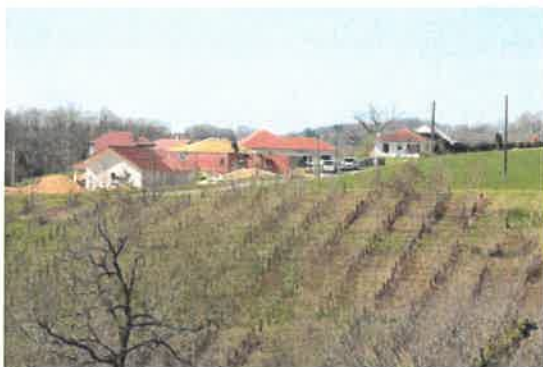
Le lotissement de Quatémás en cours de construction (2017)
