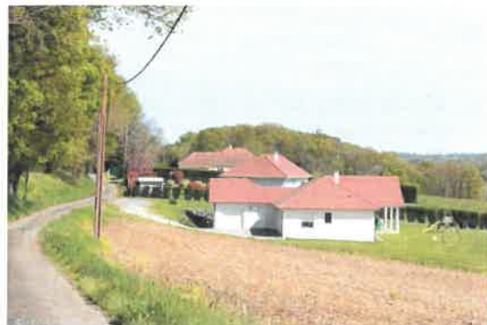
Constructions récentes (chemin de Larriou)
