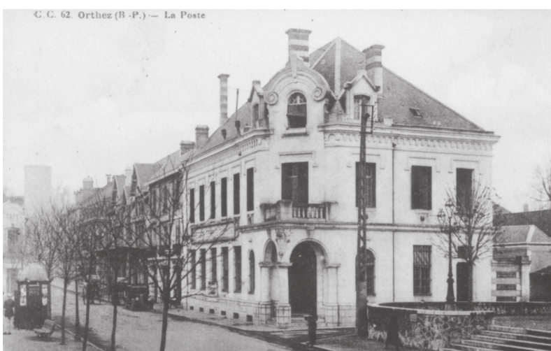
La poste vient affirmer l'articulation place d'Armes-promenade urbaine des Platanes. La tour Moncade est en toile de fond. Le morceau de paysage urbain du début du XX e siècle, est aujourd'hui disqualifié.
