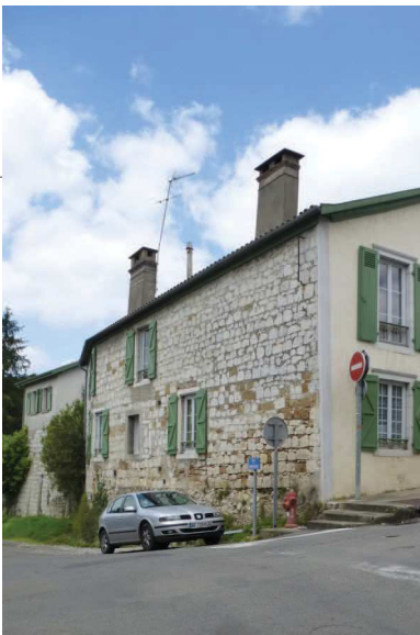
Vestiges du rempart du rempart sud du bourg castral en gros appareil calcaire assésé. Rues des Remparts et Mimonce.
