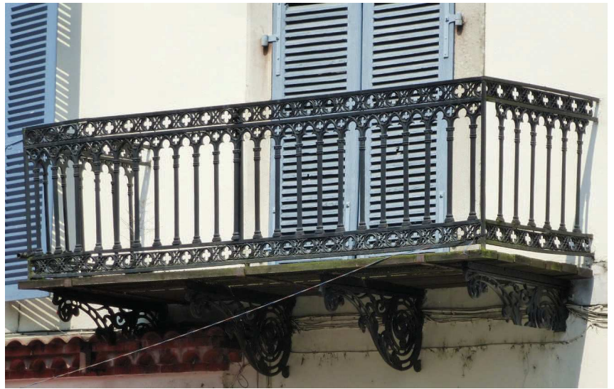
Sécuriser, orner et soutenir le balcon avec la fonte moulée
