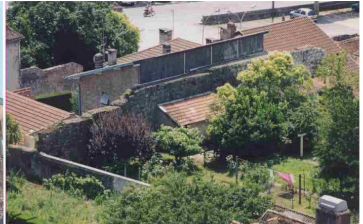
Vestiges du rempart dans les parcelles qui bordent la rue Mimonce
