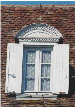
1. Lucarne à fronton incurvé; 2. Lucarne passante; 3. Lucarne jacobine; 4 lucarne à fronton triangulaire et adoucissements en forme de consoles
