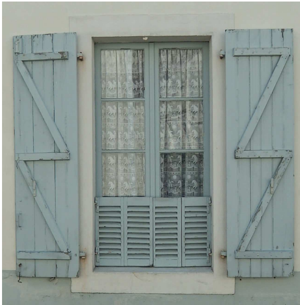
Les contrevents permettent de faire obstacle à l'air froid en hiver et aux excès du rayonnement solaire estival.
