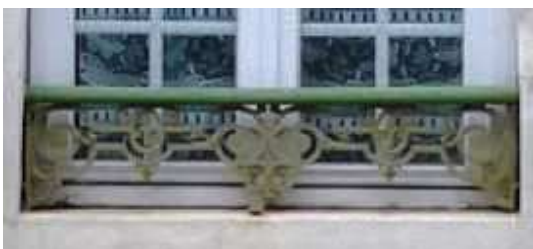
Sécuriser et orner l'appui de baie avec la fonte et le fer forgé
