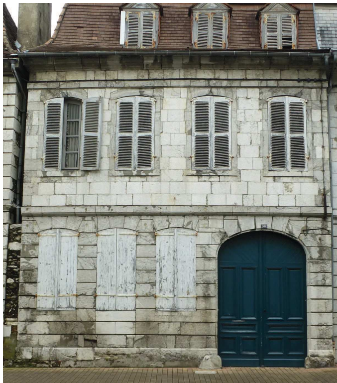
Type d'hôtel particulier avec façade à l'alignement : faitage parallèle à la rue, toit en bâtière - façade en pierre de taille et ferronneries – partie centrale à cinq travées avec portail dans l'axe de composition - partie latérale à deux travées avec porche.
