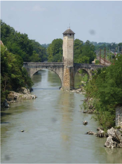
Le Pont-Vieux vu depuis le Pont-Neuf.
