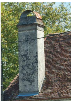
Ouvrages de toits : lucarnes charpentées et maçonnées, cheminées enduites avec leur mitre., cheminée de briques et décor de l'époque industrielle .
