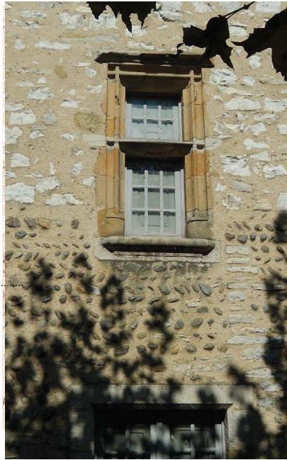
Enduit à pierre rase sur maçonnerie en moellons de calcaire
