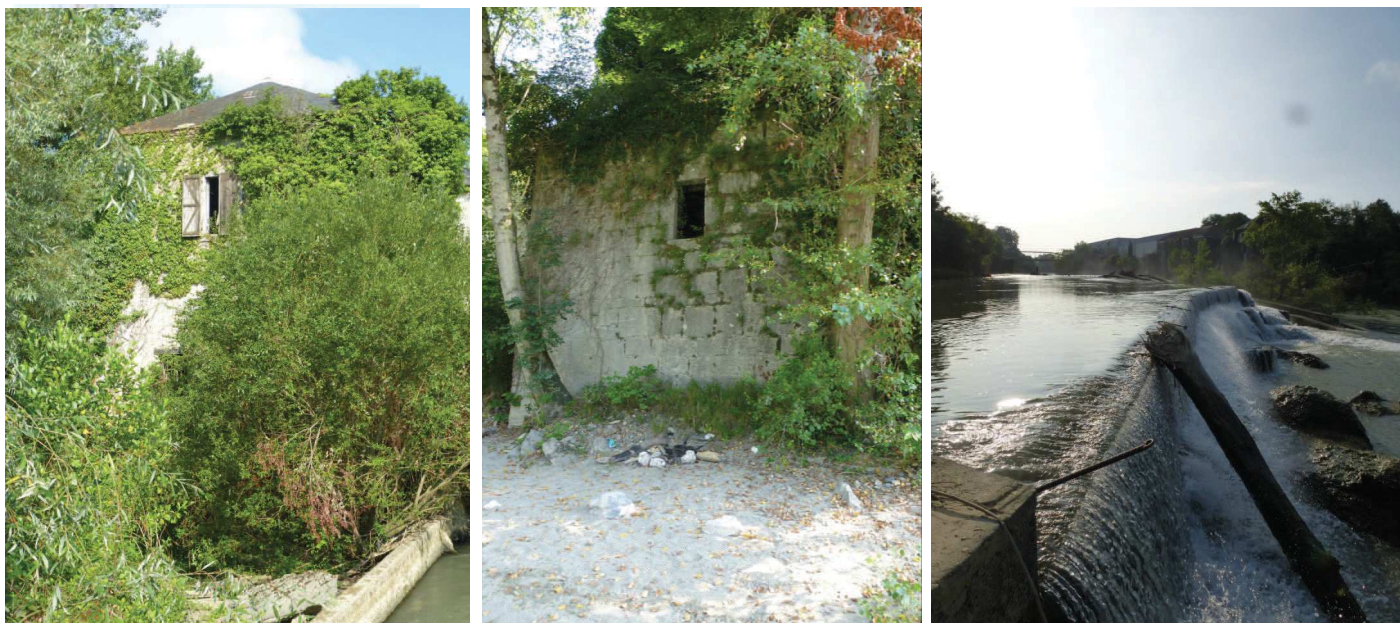
Partie ancienne du moulin vicomtal avec son gros appareil calcaire blanc, digue et passelis
