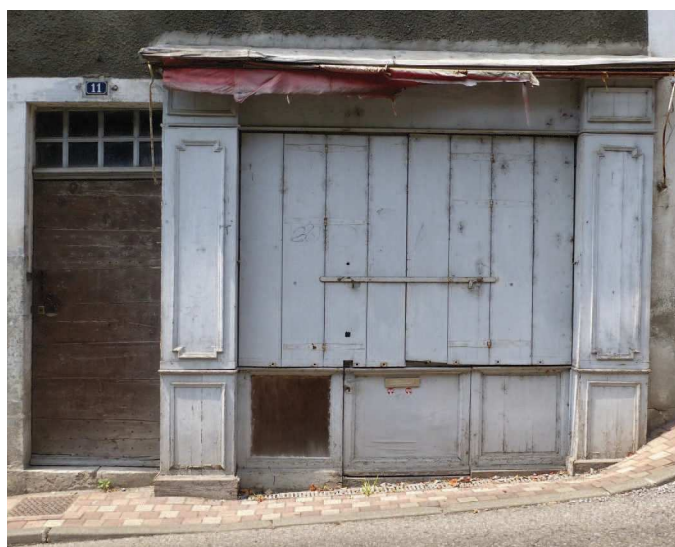
La devanture menuisée en applique sur la façade. La devanture n'intègre pas la porte d'entrée de l'immeuble.. La devanture est encore équipée de ses ais de fermeture et de son store-banne.
