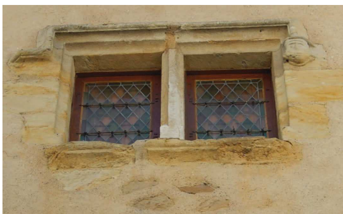
Détails d'architecture de maisons des XVe s-XVI e siècles
