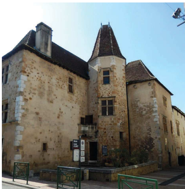
Façade sur la rue percée de grandes baies.
