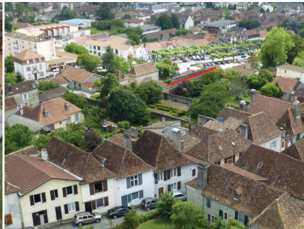
Vestiges du rempart du rempart est du bourg castral de Moncade.
