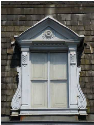
1. Lucarne à fronton incurvé; 2. Lucarne passante; 3. Lucarne jacobine; 4 lucarne à fronton triangulaire et adoucissements en forme de consoles
