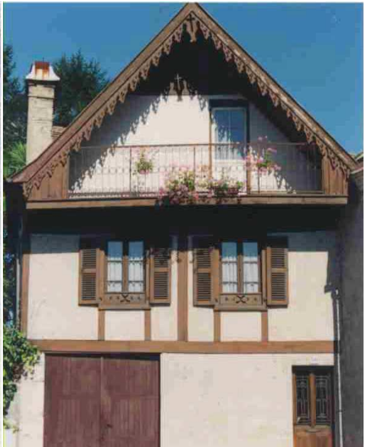
Mirande sur rue avec ses lambrequins de bois découpés aménagée sur une maison ancienne à pans de bois.
