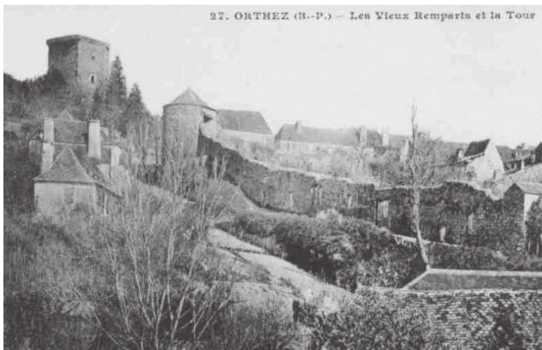
Le rempart et la tour Dufau à l'aplomb de la Poustelle et de la rue Gaston Fébus.
