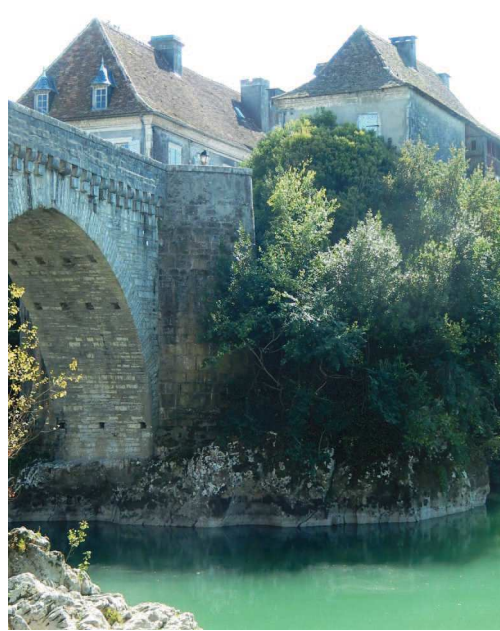
Le Pont-Vieux pile établie sur l'enrochement côté du quartier Départ
