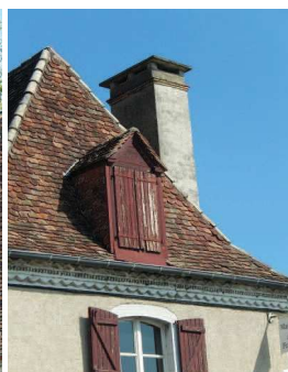
Ouvrages de toits : lucarnes charpentées et maçonnées, cheminées enduites avec leur mitre., cheminée de briques et décor de l'époque industrielle .
