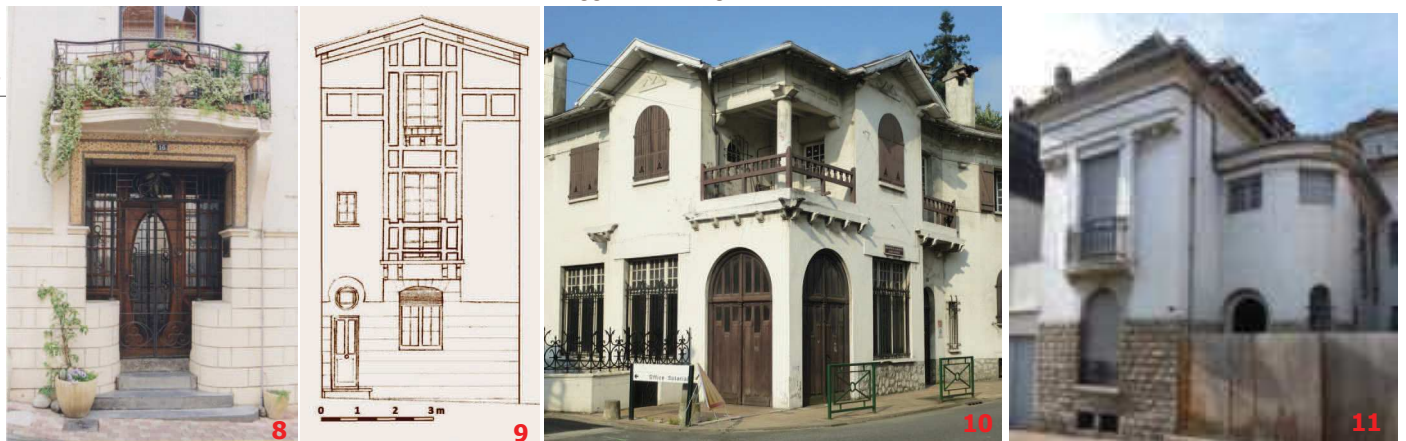
XX e siècle : 8 : Rue Bourg-Vieux, façade modernisée dans le style Art-Déco.; 9 : Façade néo-basque place du Foirail; 10 : Maison Ladebat; 11 : Maison années1930 Brossers.
