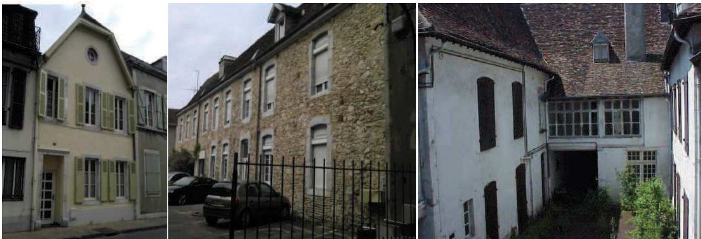
Maisons mitoyennes du centre et des faubourgs anciens. Différentes typologies sont observables : façades étroites et larges, nombres de niveaux avec ou sans combles aménagés, maisons organisées autour d'une cour; appareil de pierre tout venant.
