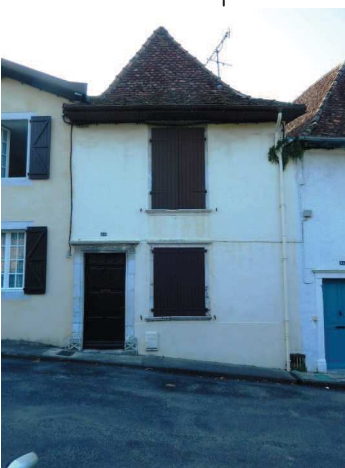
une travée principale dans l'axe; La porte est sur une travée secondaire de côté.
