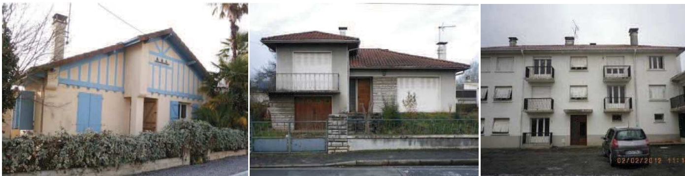
218 Maisons récentes des faubourgs (2 e partie du XX e siècle). Typologies: maisons non mitoyenne ou immeubles collectifs; matériaux : blocs de béton creux ou béton banché.
