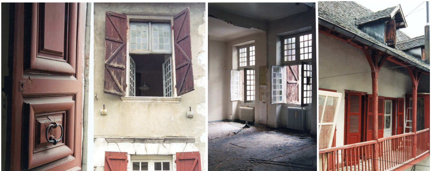
Détails de menuiseries de porte, fenêtre à croisée de bois et partition à petits carreaux. Galerie sur cour intérieure
