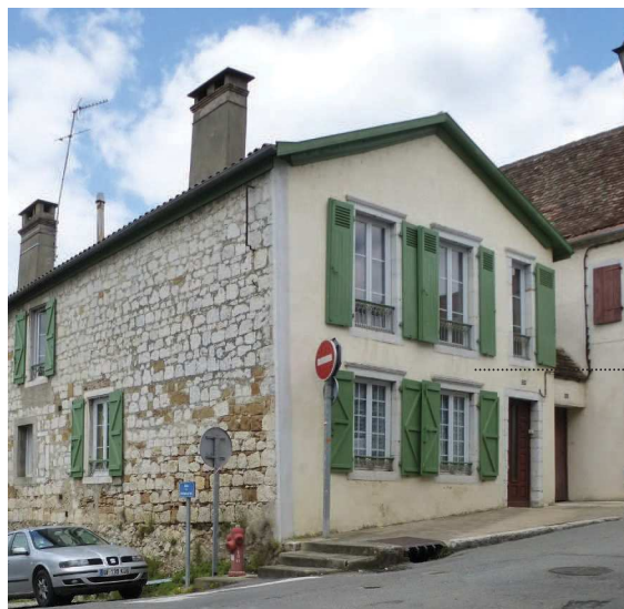
Encadrements en calcaire laissés apparents
