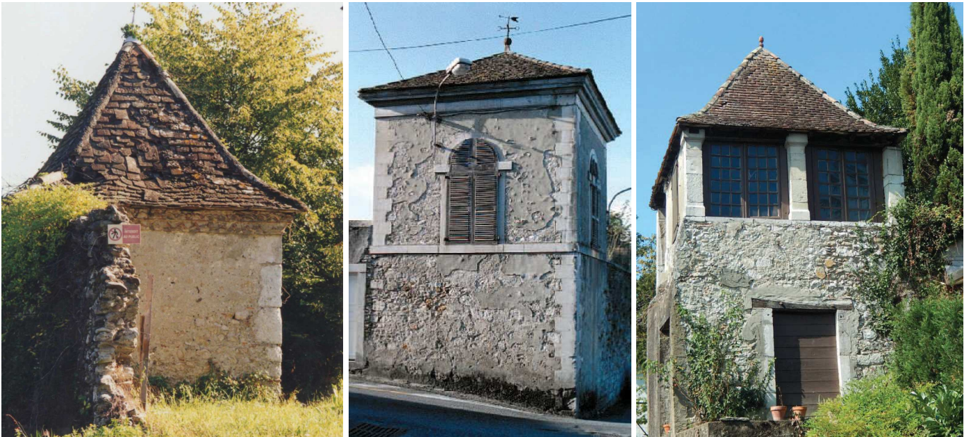
Pavillons avec toitures à l'impériale en tuiles plates et en ardoises. A droite, structure de pans de bois et bardage d'ardoise sur la face exposée aux vents dominants.
