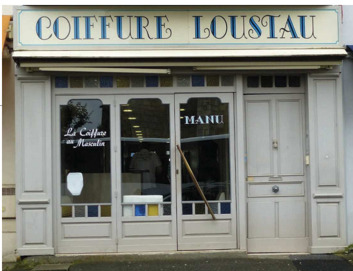
La devanture menuisée en applique sur la façade. La devanture intègre la porte d'entrée de l'immeuble.
