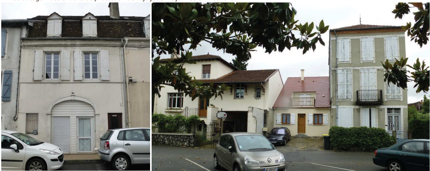
Non respect des encadrements, formes et matériaux des menuiseries
