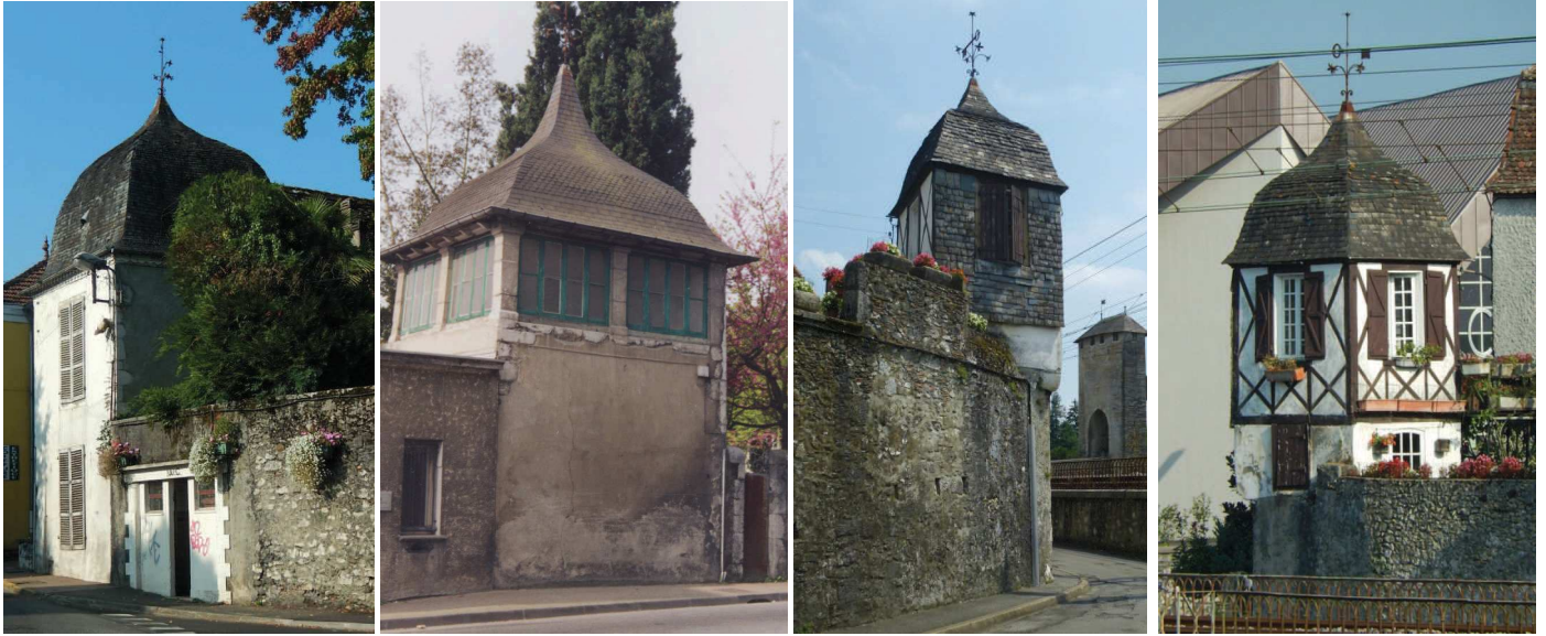
Pavillons avec toitures à l'impériale en tuiles plates et en ardoises. A droite, structure de pans de bois et bardage d'ardoise sur la face exposée aux vents dominants.
