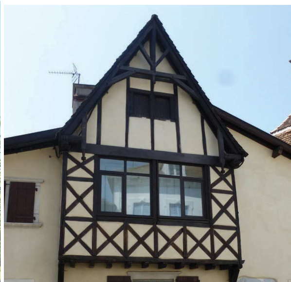
Pan de bois enduit et panneaux enduits.
