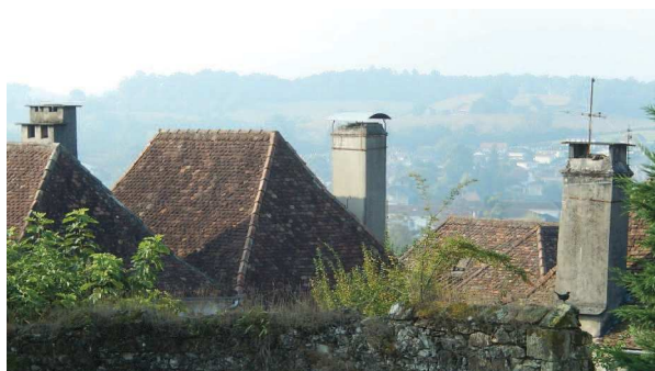
Ouvrages de toits : lucarnes charpentées et maçonnées, cheminées enduites avec leur mitre., cheminée de briques et décor de l'époque industrielle .
