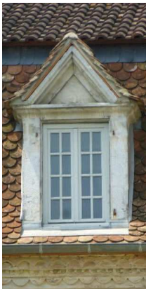
1. Lucarne à fronton incurvé; 2. Lucarne passante; 3. Lucarne jacobine; 4 lucarne à fronton triangulaire et adoucissements en forme de consoles
