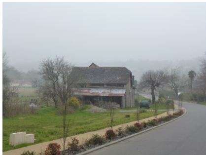
Hangar agricole, toit en ardoise, mais apenti en taule ondulée qui dévalorise l'ensemble
