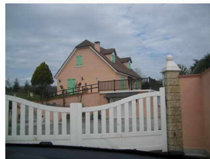
Bâtiment pavillonnaire en R+1+combles, lucarnes de type chien-assis,
