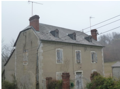
Bâtiment traditionnel du centre bourg en R+1+combles
