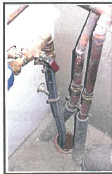
Calfeutrage des entrées de réseaux
