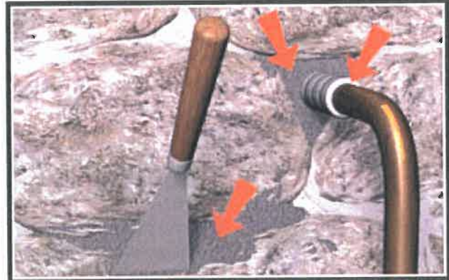
Situation après travaux de colmatage
