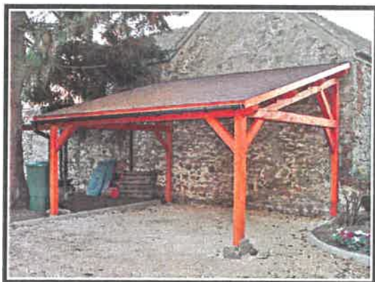
Construction annexe adossée
