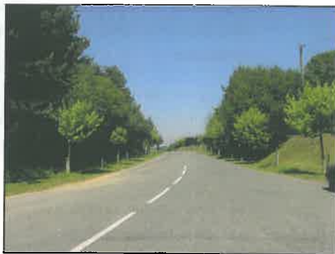
Au droit de la RD 315 – quartier Coutot
