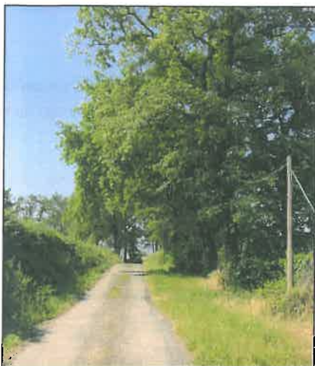
Au droit de la VC dite de Bergeras
